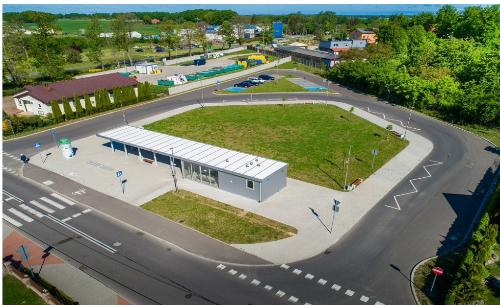
Centrum przesiadkowe w Gościnie
